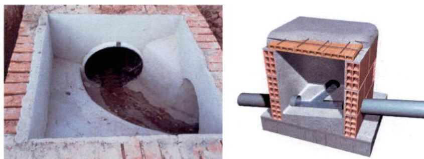
Figura 1 – Fundo das caixas de inspeção
